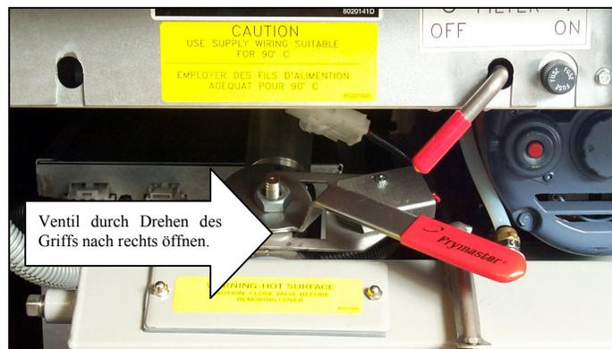
Das Ablassventil in der Fritierwanne öffnen und das Öl in die Filterwanne ablaufen lassen.
